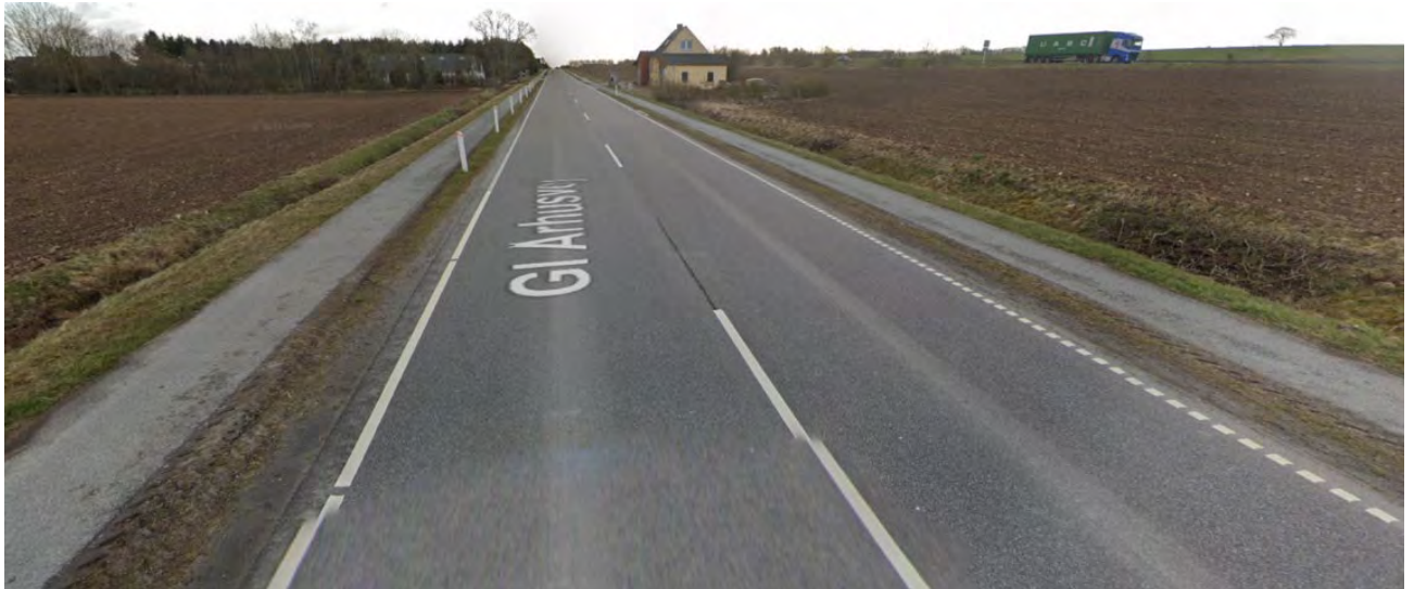
Figur 1-7 Udformning af Gl. Århusvej. Billedet er taget øst for Scandiavej i østgående retning. Kilde: Google Maps, 2022.
